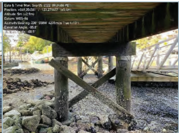
012. Timber Pier Soffit
