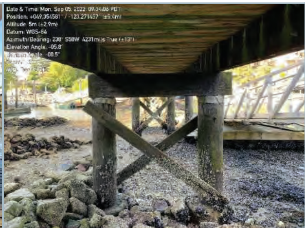
012. Timber Pier Soffit
