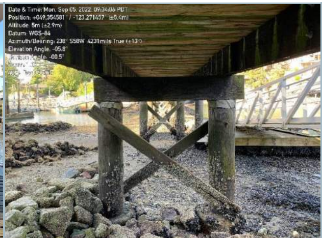
012. Timber Pier Soffit
